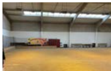
Remise en peinture du boulodrome
