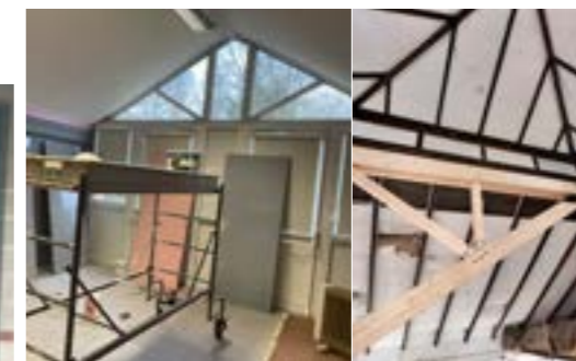
Remise en peinture du foyer Gonthier dont la charpente a été renforcée.
