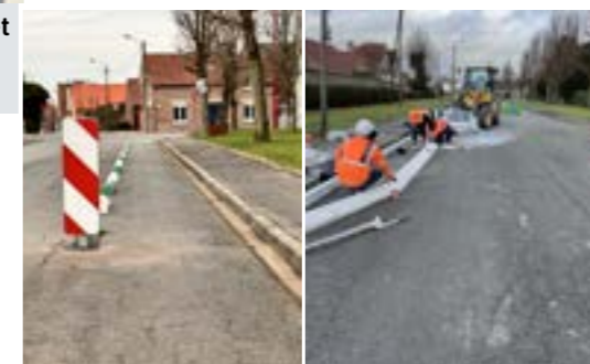
Pose d'une écluse et de panneaux réfléchissants, avenue de Noyon.
