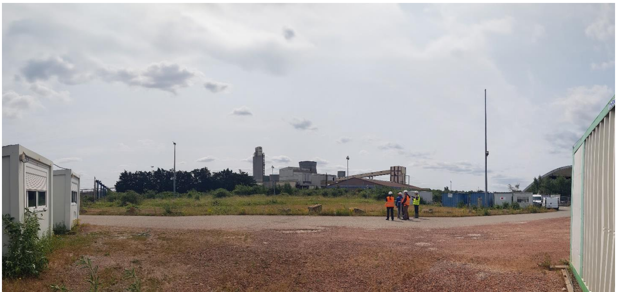
Vue latérale sur le terrain à construire
