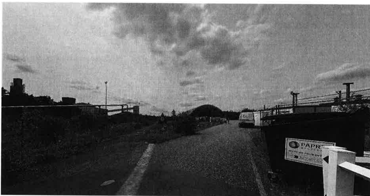
Vue Nord-Est de l'accès au terrain
